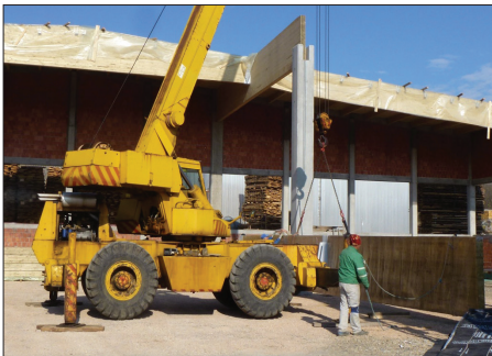
Слика 1. Конструктивна греда од лепљеног ламелираног дрвета на производном погону фабрике намештаја у изградњи у Србији (фото: Главоњић, 2014)
