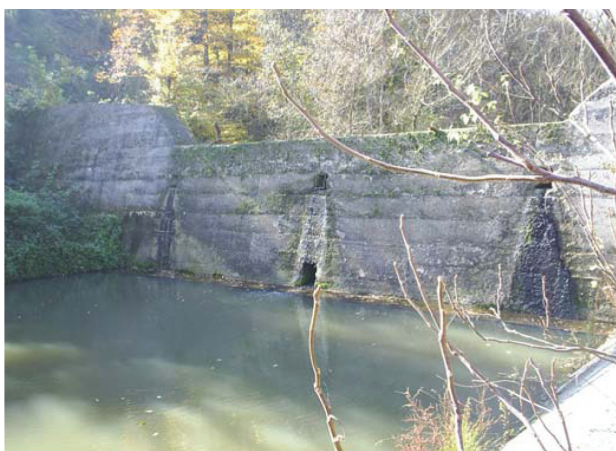
Fig. 1. Check dam on the river Bačevička Reka (V. Matić).
