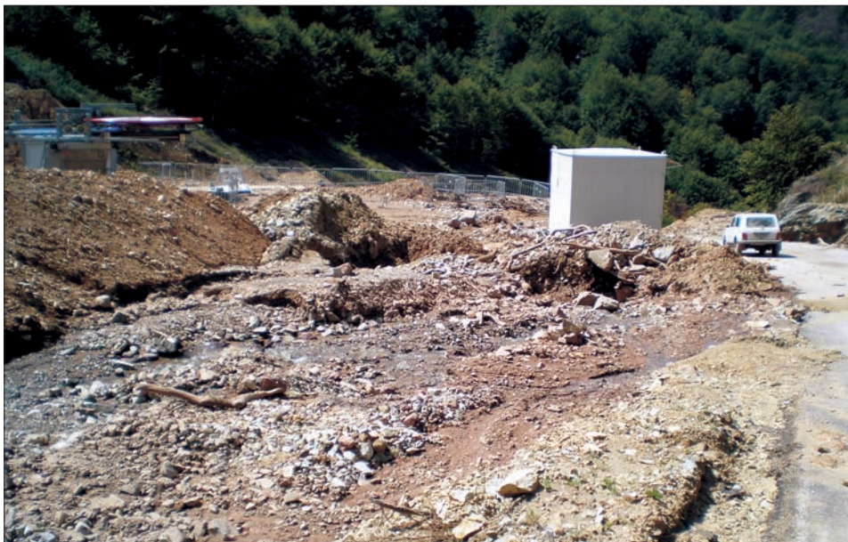
Слика 4. Површински отицај на ски-стази „Коњарник“ угрозио је полазну станицу жичаре и приступни пут (Стара планина, август, 2007. год.)
