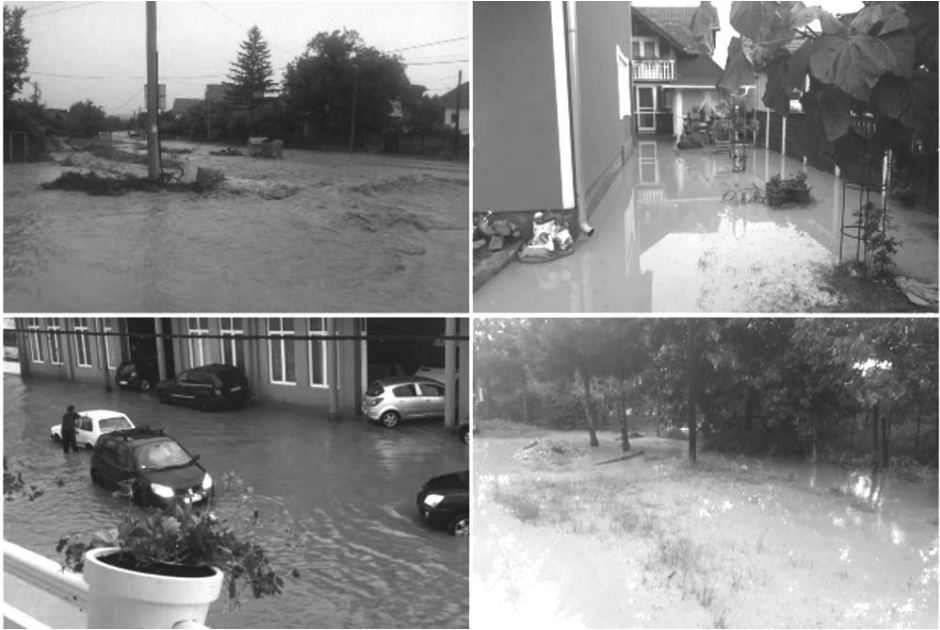
Слика 3. Последице бујичне поплаве у Петровцу (5)
