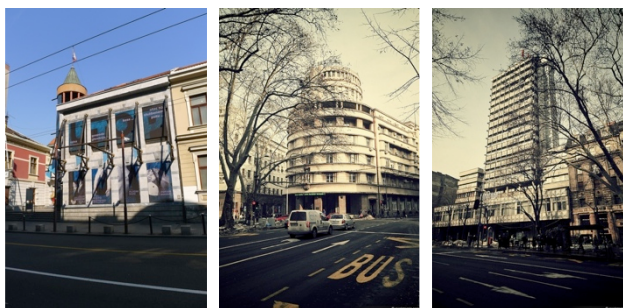
Прилог 314: Потез Македонске и Светогорске улице_Објекти са доминатним садржајем: а) Атеље 212, б) Радио Београд и в) Зграда дневног листа Политика. Извор: Аутор и Flickr. com
