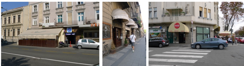
Прилог 337: Надстрешнице од меких материјала: а) Једноставна, конзолно постављена тенда у Светогорској улици, б) Полукупола изнад излога угоститељског објекта у Светогорској улици и в) Полуцилиндрична надстрешница у Улици Вука Караџића
