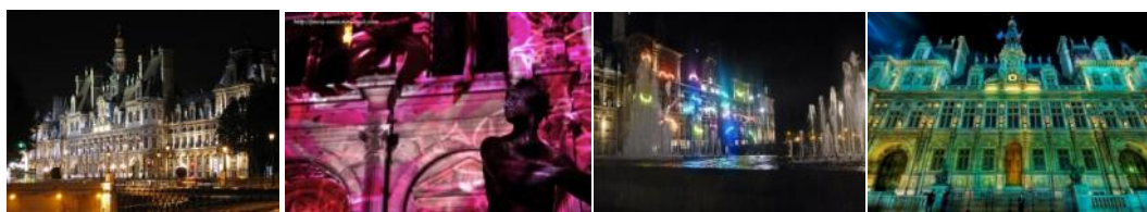
Прилог 62: Hotel de Ville: (1) Пројектовано осветљење објекта; (2) Осветљење објекта у част обележавања манивистације Octobre Rose; (3) Осветљење током Nuit Blanche и (4) Осветљење током трајања рок фестивала.
